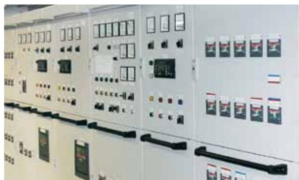
управление ДГ, автоматическую синхронизацию ДГ с шинами ГРЩ, запуск ДГ по обесточиванию шин ГРЩ, запуск резервного ДГ при неисправности / перегрузке работающего ДГ, автоматическое распределение нагрузки между работающими ДГ, стоп ДГ по низкой нагрузке и т.д.
