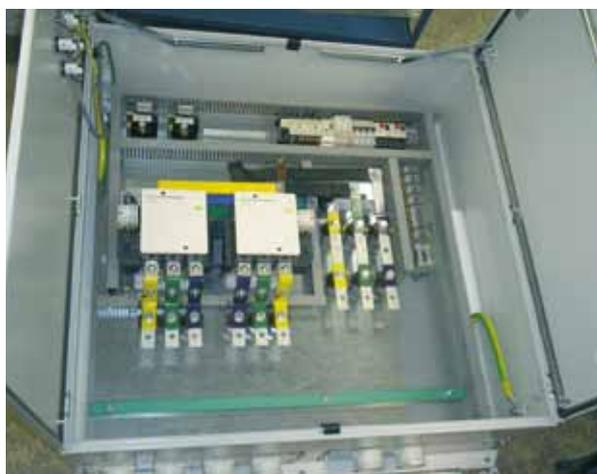
**А**втоматические переключатели сетей (АПС) предназначены для автоматического переключения питания потребителей с основной сети на резервную при исчезновении напряжения в основной сети и автоматического переключения с резервной сети на основную при восстановлении в ней напряжения, световую сигнализацию о наличии напряжения в основной и резервной сети.
