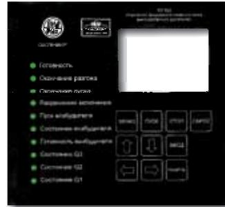
Рис. 9.2 Панель управления устройством безударного пуска высоковольтных электродвигателей
